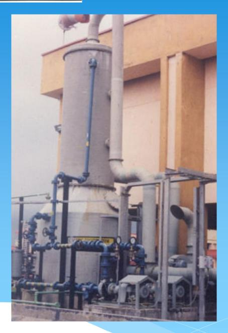
CHLORINE GAS LEAK DETECTOR ABSORPTION SYSTEM
